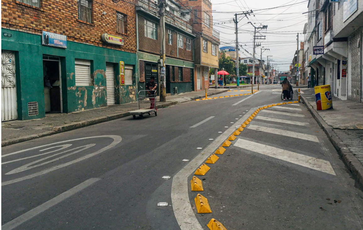
Figura 4. Medidas de tráfico calmado implementadas en Bogotá para el cumplimiento de límites de velocidad. Foto: Natalia Lleras
