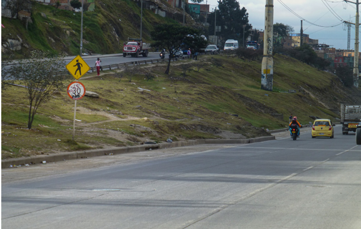
Figura 3. Mala coordinación entre límites de velocidad y la infraestructura. Foto: Natalia Lleras
