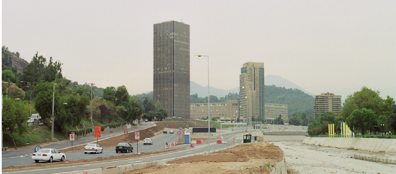
Figura 1. Construcción de la autopista Costanera Norte en Santiago, Chile. Foto: Claudio Olivares Medina
