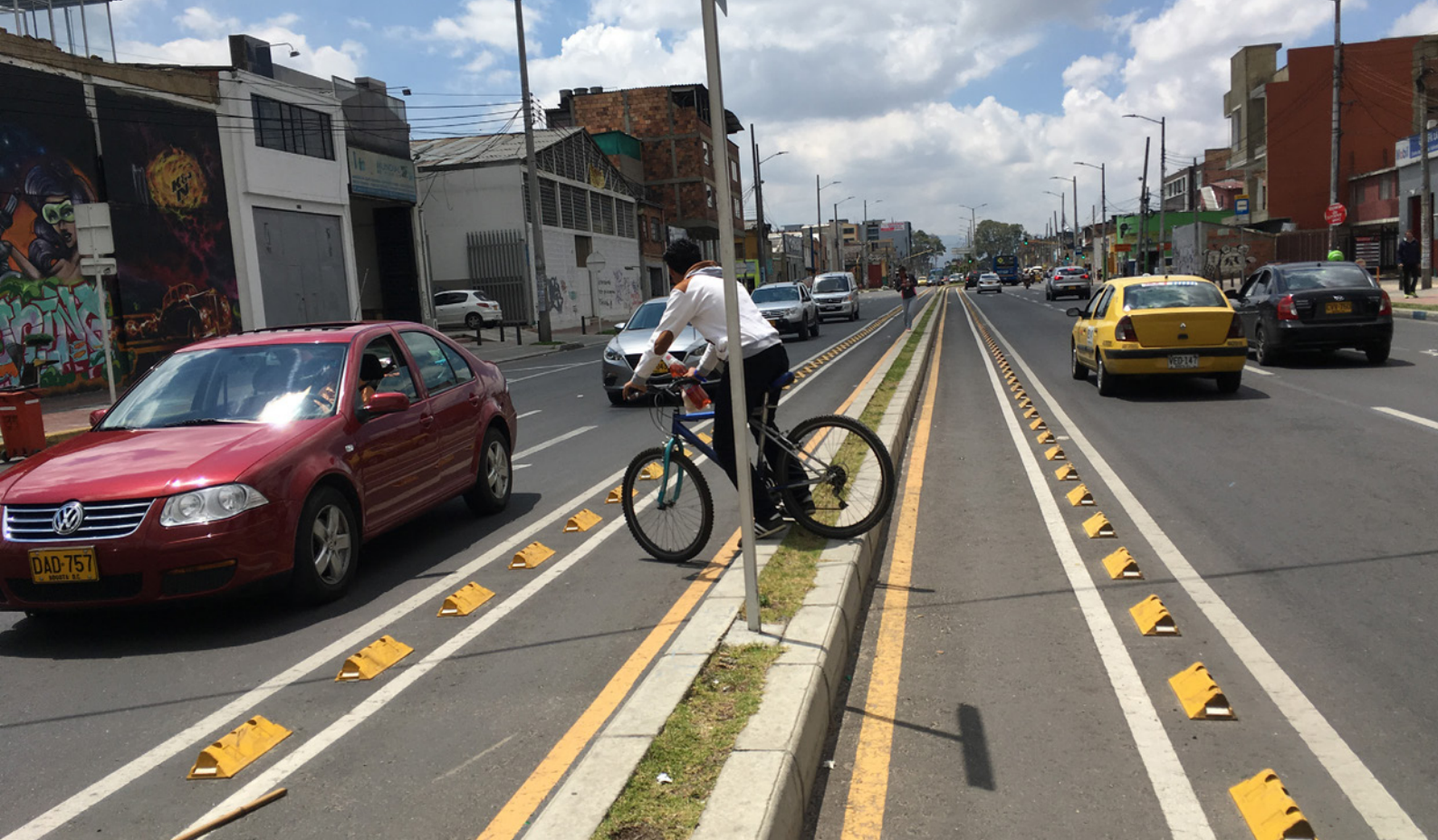
Figura 6. Las ciclovías en el carril central pueden generar problemas de acceso y seguridad, acá un ejemplo en Bogotá (Carrera 24). Foto: Carlosfelipe Pardo
