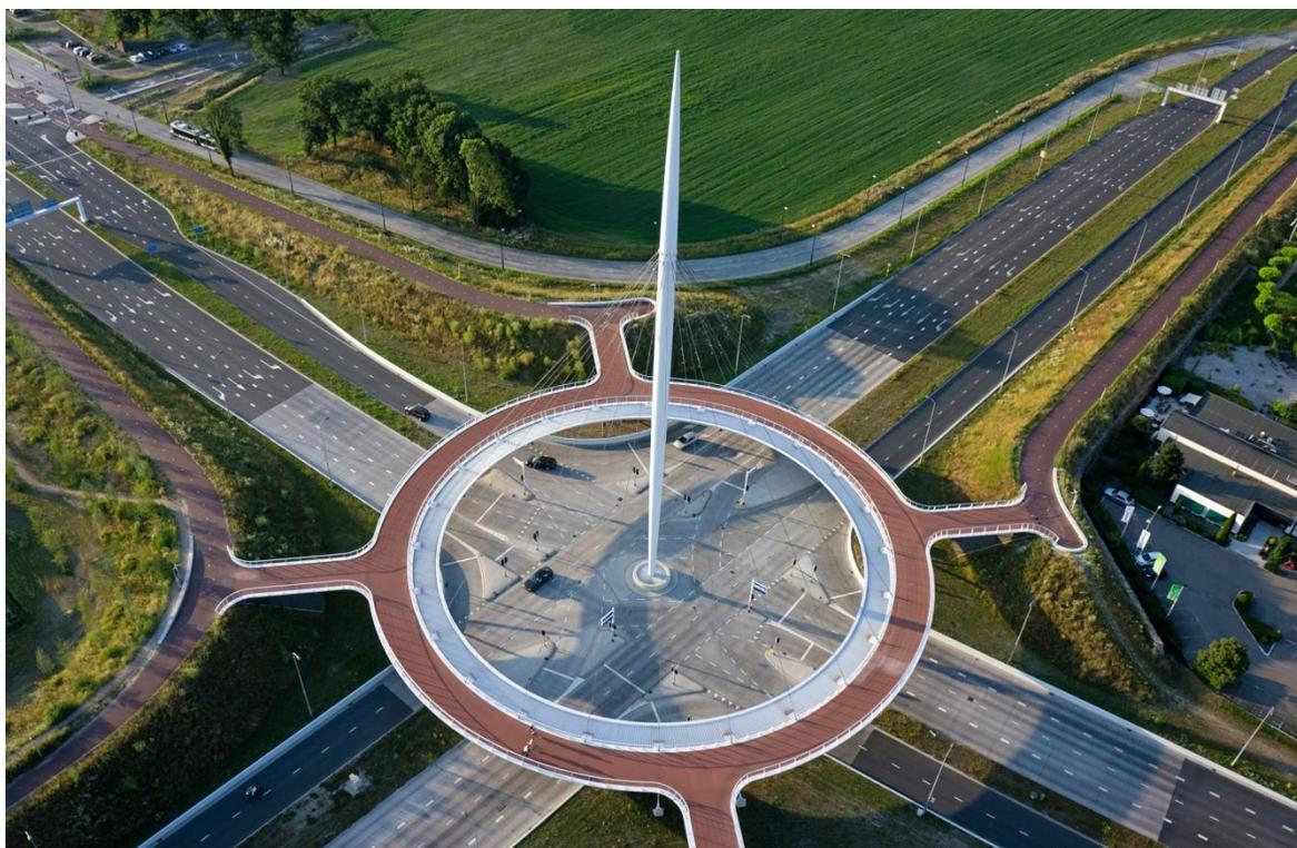
**Figura 21.** La 'Hovenring' en Eindhoven, la primera glorieta suspendida para bicicletas del mundo. Diseño y foto por ipv Delft.
